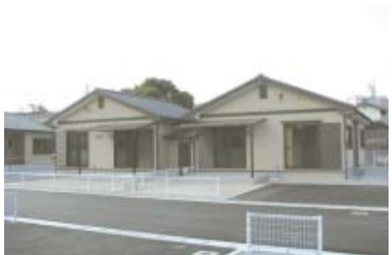
▲(写真5)市営小板井住宅建替事業
