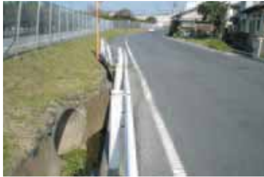
小郡駐屯地南側排水溝
