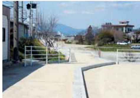
▲端間駅東側の歩道整備
