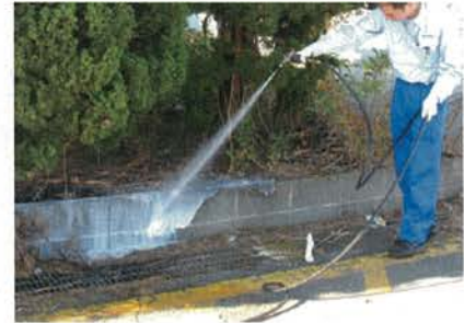
専門業者による液剤の高圧散布
