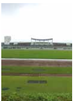
▲小郡市陸上競技場
